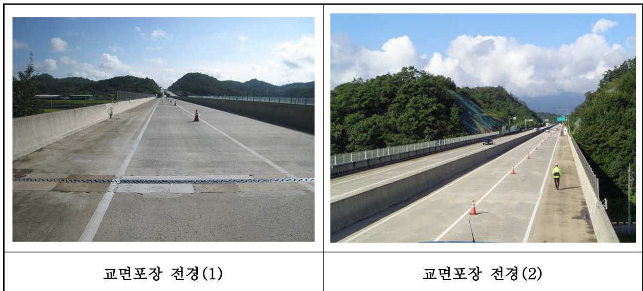
【사진 21.3.19】 교면포장 전경
