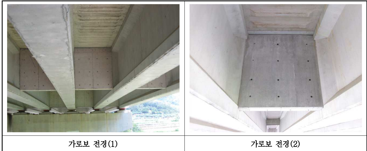
【사진 31.3.31】 가로보 전경
