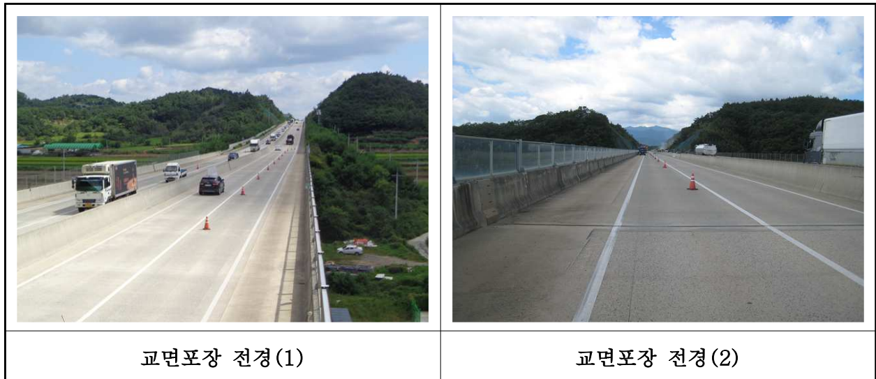
【사진 21.3.44】 교면포장 전경
