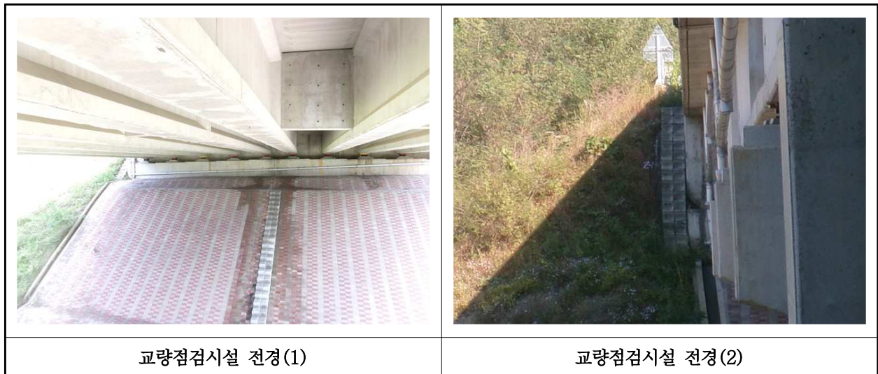
【사진 25.3.25】 교량 점검시설 전경
