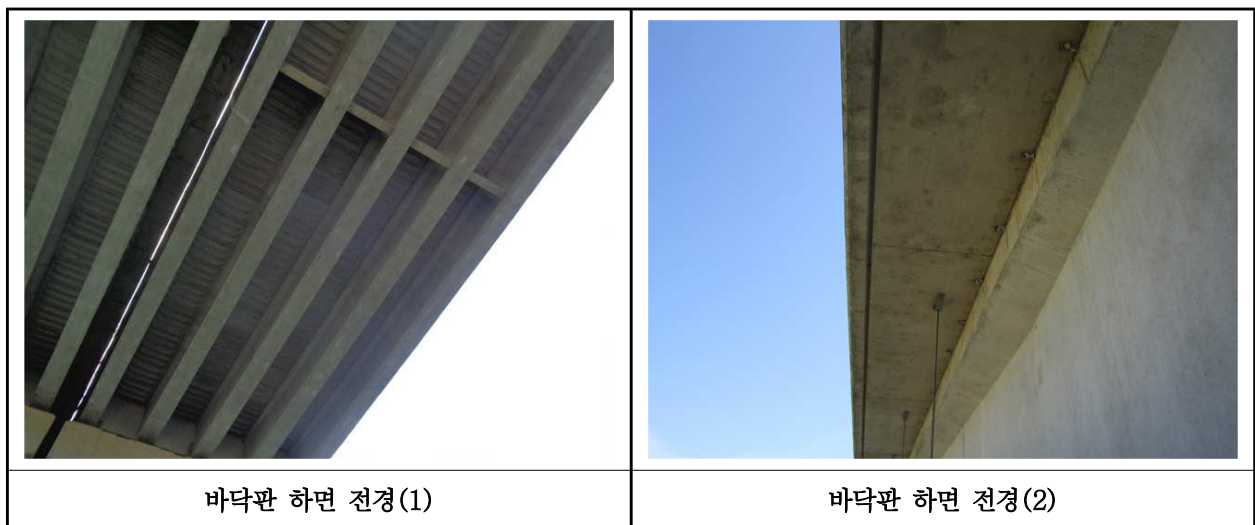
【사진 21.3.2】 바닥판하면 전경
