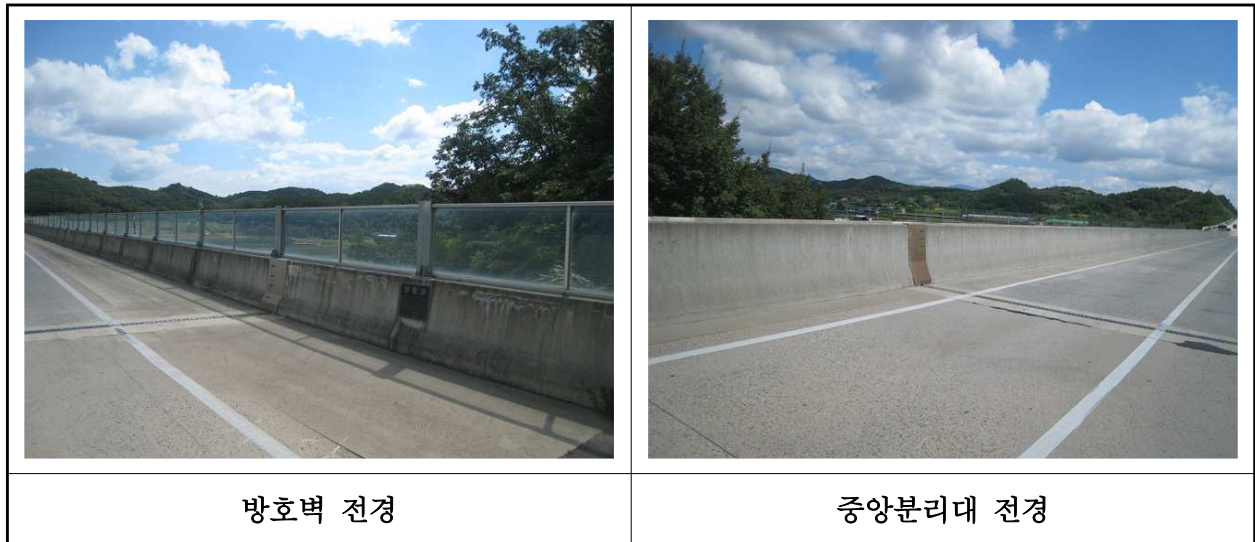
【사진 21.3.48】 방호벽 및 중앙분리대 전경
