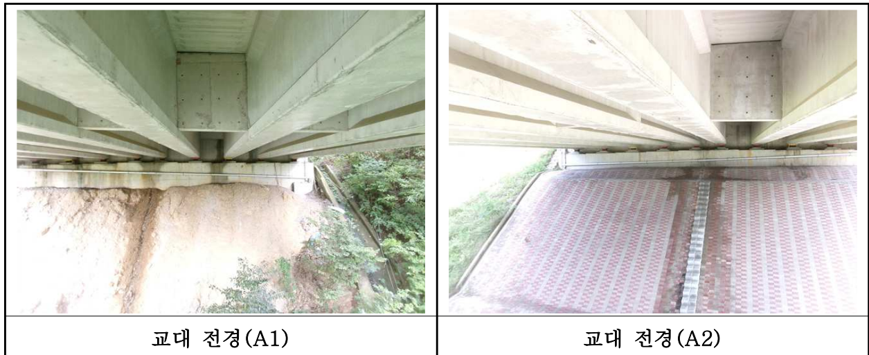
【사진 21.3.8】 교대 전경
