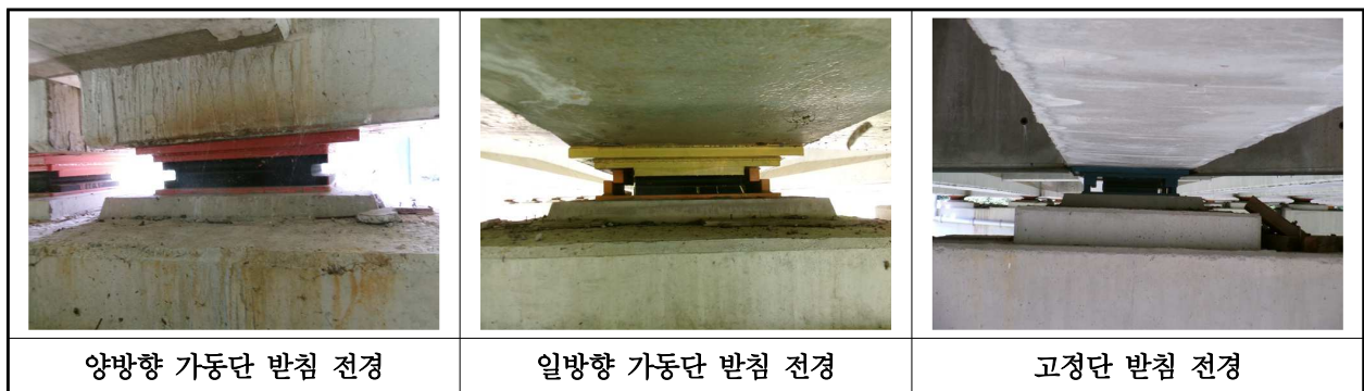
【사진 21.3.37】 교량받침 전경
