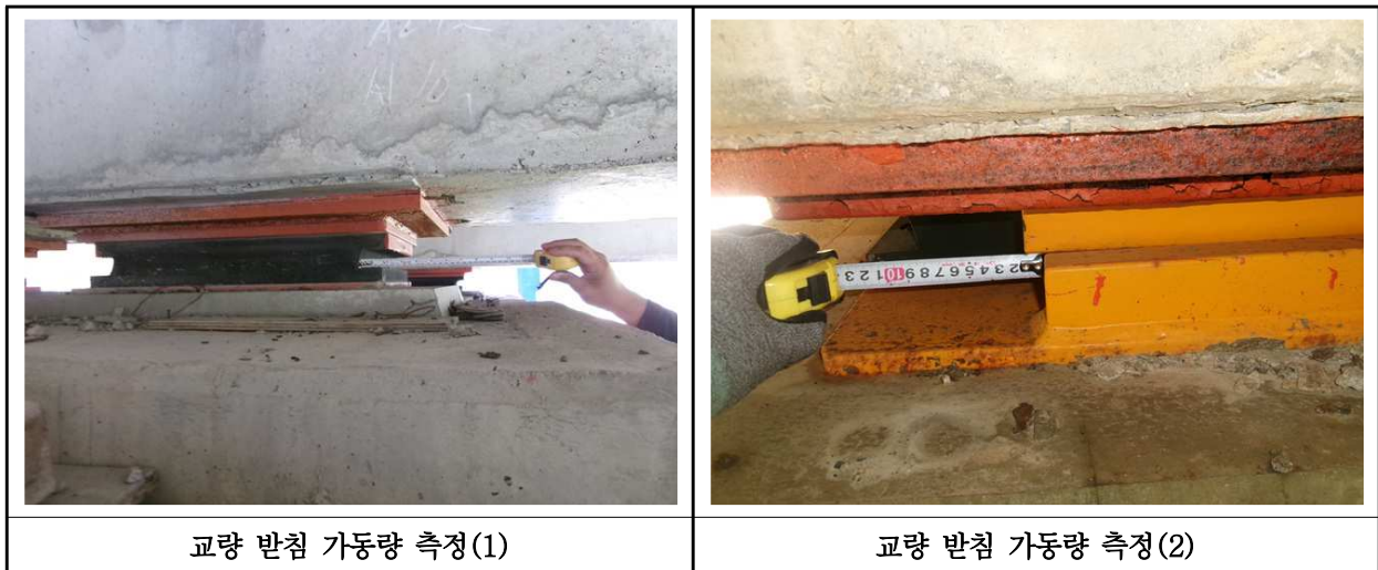
【사진 21.3.15】 교량받침 이동량 측정
