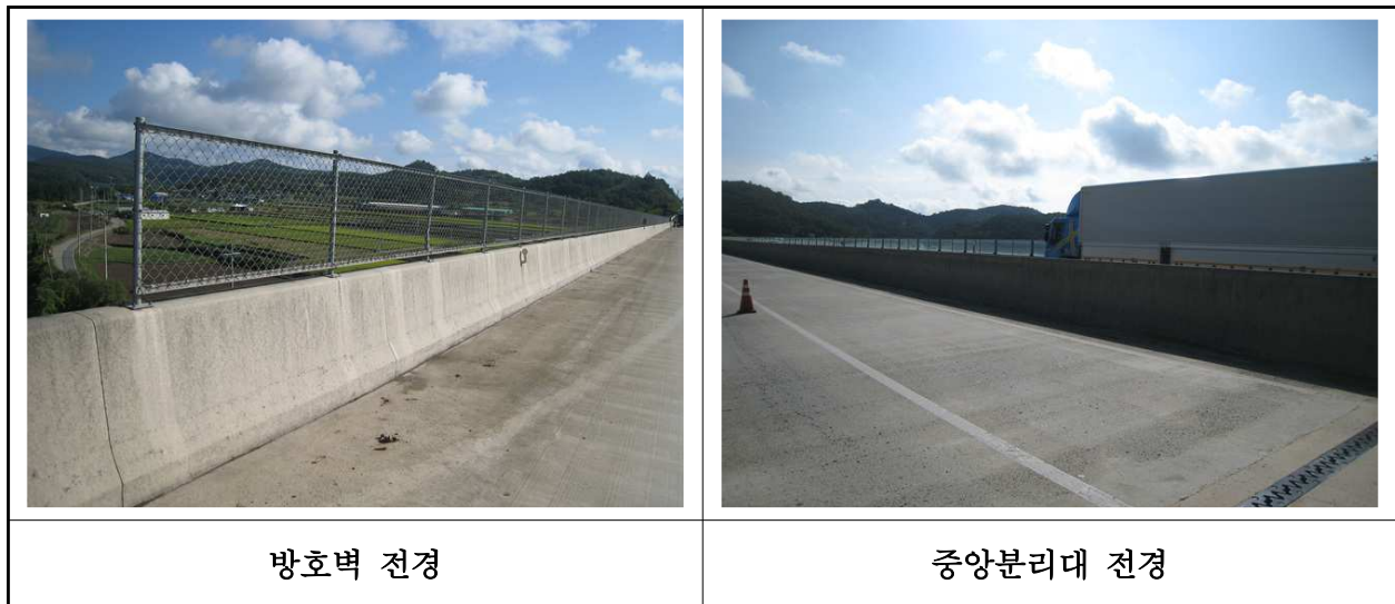
【사진 21.3.23】 방호벽 및 중앙분리대 전경
