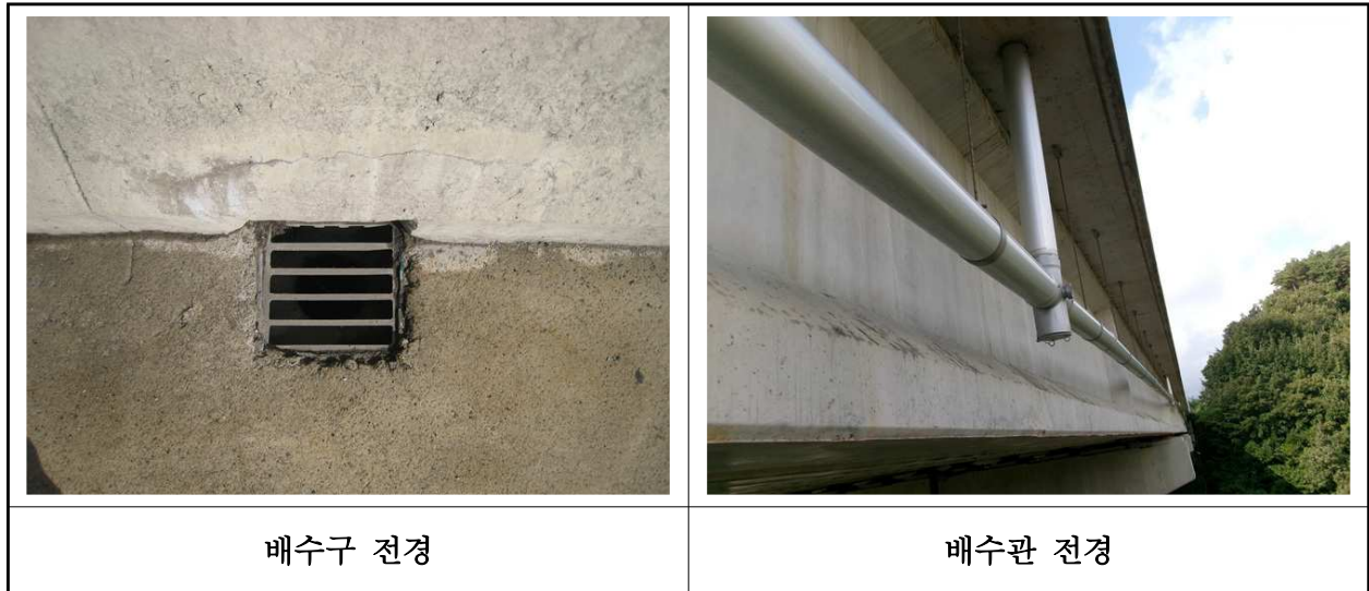
【사진 21.3.21】 배수시설 전경
