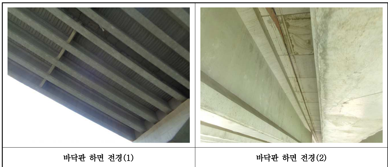
【사진 21.3.27】 바닥판하면 전경
