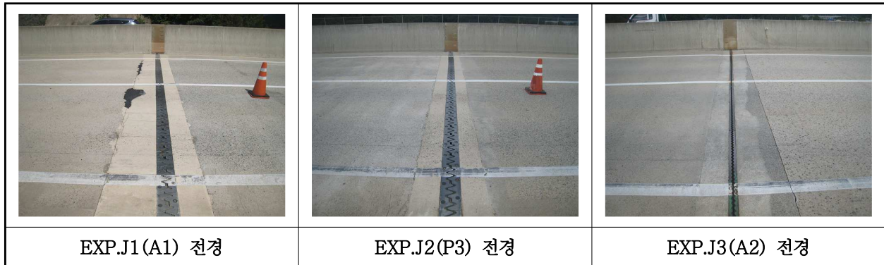
【사진 21.3.41】 신축이음장치 전경
