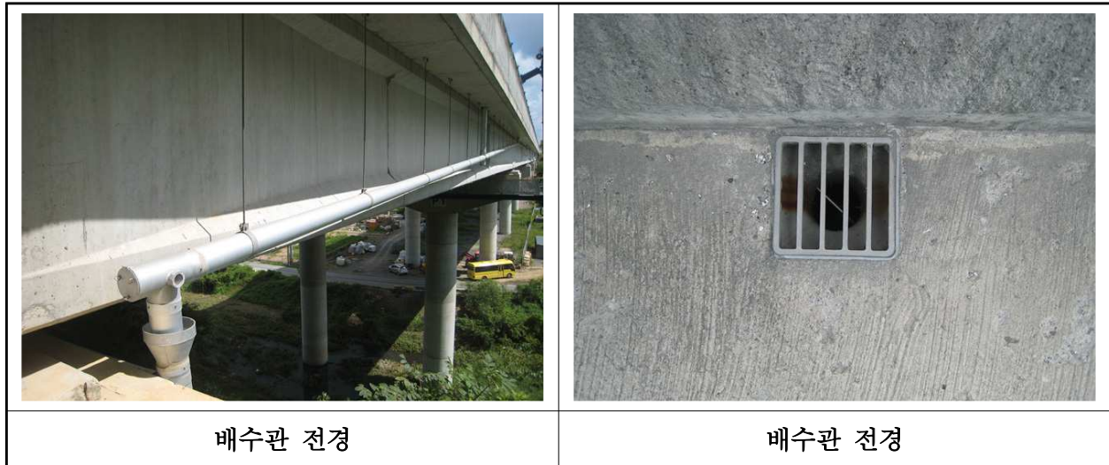
【사진 21.3.46】 배수시설 전경
